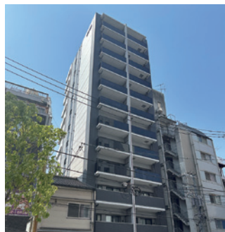
セントヒルズ銀山町参番館 12階建(2023年2月 竣工)
