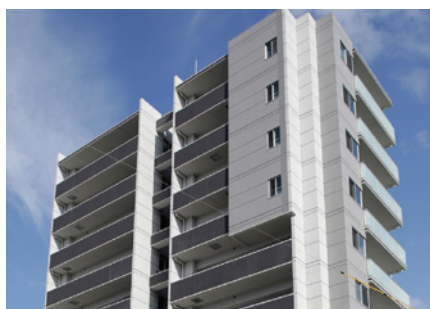
セントエクシア段原東 総戸数18戸(2014年2月 竣工)
