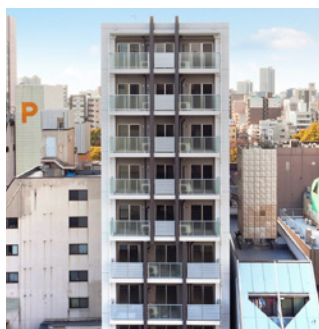
セントヒルズ並木 11階建(2011年1月 竣工)
